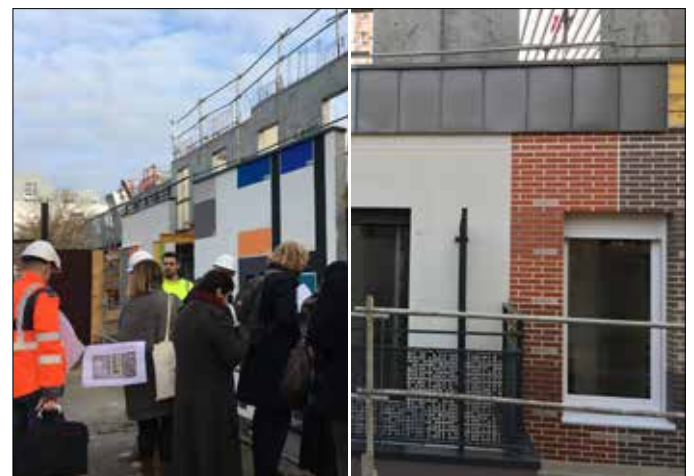
Suivi de la qualité architecturale, validation des échantillons, ZAC Cergy-Puiseux
